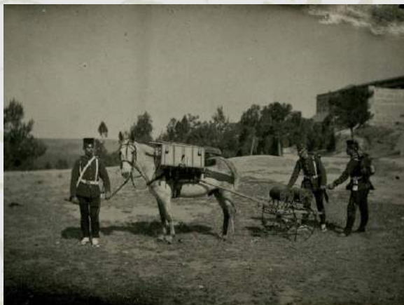
Tendido de línea a carretilla
